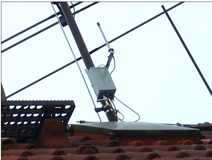
Obr.1 - Gateway umístěná na stožáru televizní antény domku hrázného
